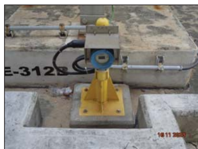
รูปที่ 3.54 Hydrocarbon Gas Detector
