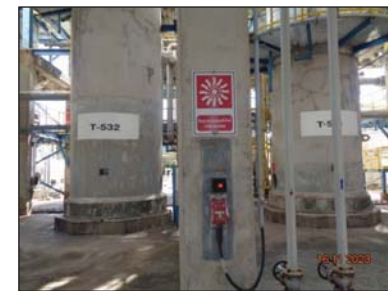
รูปที่ 3.46 Fire Alarm System
