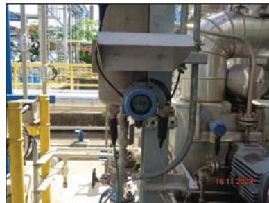
รูปที่ 3.40 Pressure/Temperature Indicator
