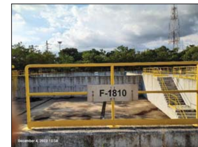
รูปที่ 3.60 บ่อกักเก็บสารเคมี F-1810
