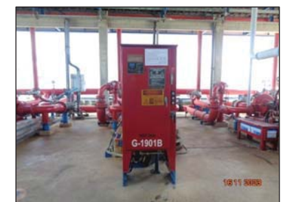
รูปที่ 3.57 เครื่องสูบน้ำดับเพลิง ชนิดไฟฟ้า
