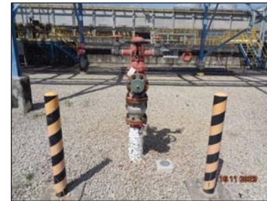
รูปที่ 3.44 Fire Water Hydrant
