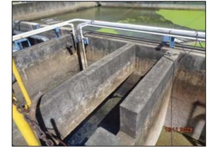
รูปที่ 3.9 Wastewater Holding Pit (F-1801)
