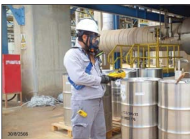
รูปที่ 3.6 การสูบล้างสารเอทิลีนไดคลอไรด์
