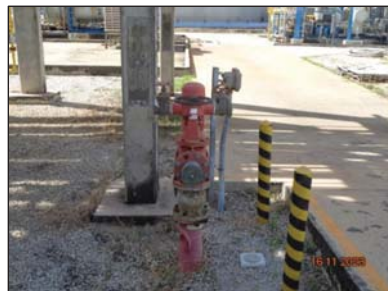
รูปที่ 3.43 Fire Water Monitor
