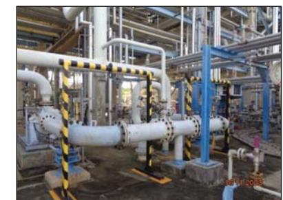
รูปที่ 3.37 Check Valve
