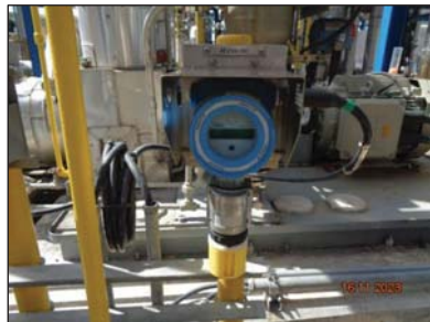
รูปที่ 3.52 Flammable Gas Detector
