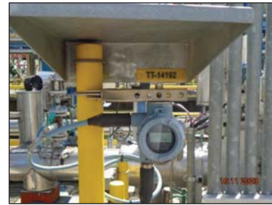
รูปที่ 3.51 High Temperature Interlocks
