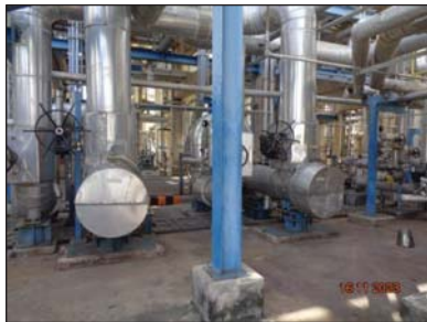
รูปที่ 3.14 Acoustic Insulation (G-624 A/B)
