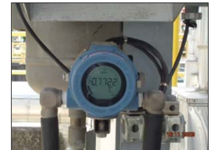
รูปที่ 3.45 เครื่องตรวจวัดอุณหภูมิ บริเวณถังเก็บเอทิลีนออกไซด์
