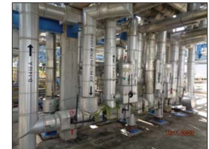
รูปที่ 3.35 อุปกรณ์ที่เกี่ยวข้องกับเอทิลีนออกไซด์ ที่ทำจาก Stainless Steel
